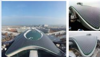
● 용산푸르지오 씨앗 태양광발전설비 설치(180kW급)
