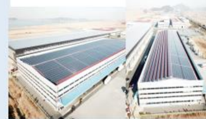
● 포항 스틸폴라워 태양광발전설비 설치(200kW급) / 박막모듈
